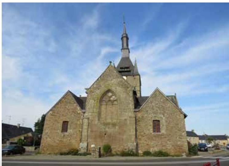
Les décisions devraient être prises dans les prochaines semaines pour débiter les travaux. A noter : 8 jauges ont été posées au niveau des fissures de l'édifice en mars 2020 afin d'instrumenter certaines fissures présentes sur l'église et mesurer leur évolution sur une année. Cette instrumentation va servir au bureau d'études structure associé à l'architecte pour déterminer si les désordres sont stabilisés ou s'ils trouvent leur origine dans des problématiques géotechniques.
