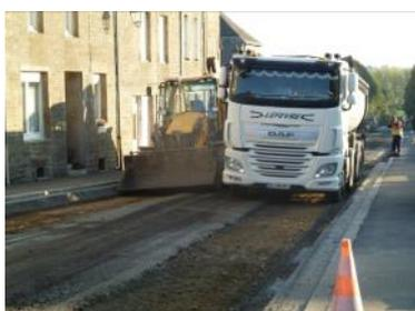
L'aménagement de la circulation, rue de la Colmont, l'élargissement de trottoirs, la réalisation d'un plateau surélevé, la mise en place de bandes de résine et la signalétique ont été réalisés lors de cette deuxième tranche de travaux. Réduire la vitesse sans trop de contraintes (circulation apaisée recommandée par les services de l'état), tel est l'objectif de ces aménagements, afin de sécuriser les personnes dans notre centre bourg.
